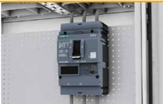
Interruttore scatolato 3VA2, 250 A, con sganciatore elettronico di sovracorrente elettronico serie ETU-8 – installato in un armadio elettrico di controllo.
