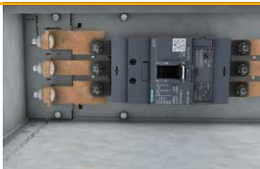
Interruttore scatola 3VA1, 100 A, con sganciatore magnetotermico di sovracorrente installato in un quadro di distribuzione di bassa tensione.
